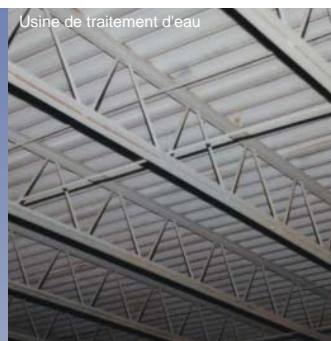
Usine de traitement d'eau
